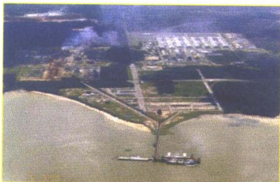
Complexo de Alumínio – Vila do Conde
