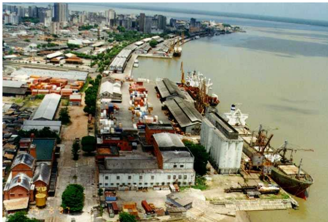
Fotografia 2- Área do Porto de Belém antes da REVAP de 1990 Fonte: http://www.cdp.com.br
