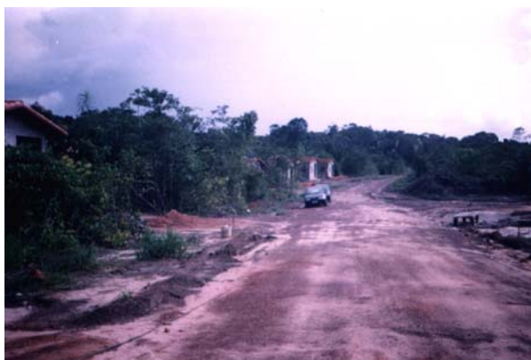
Figura 05- Área em construção do reassentamento do Curuperé
