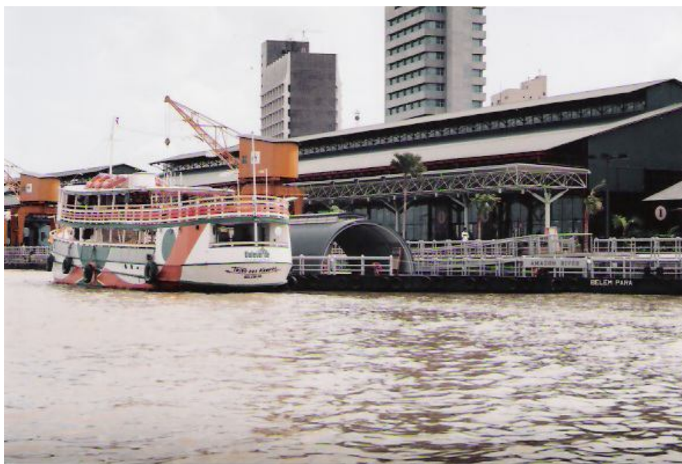
Foto 03: Terminal Hidroviário de Passageiros
