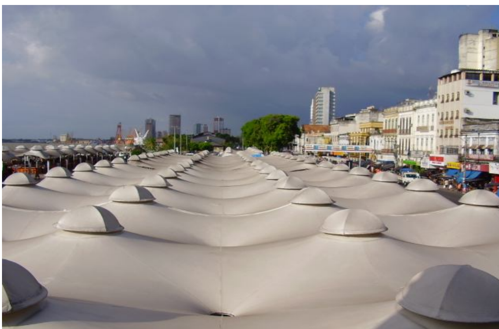
Foto 16: Sistema de “Tendas” Tencionadas
