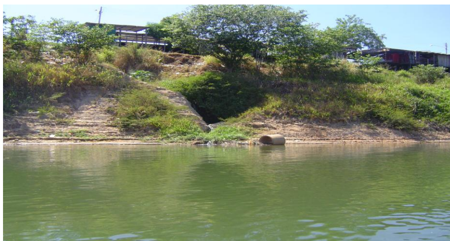
Figura 5: Esgoto lançado no rio Tocantins Fonte: A. E. de Pinho da Silva, 2005
