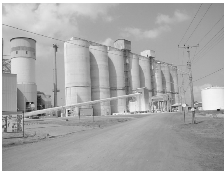
Figura 2.3: Silos de armazenamento do caulim no terminal portuário da Imerys
