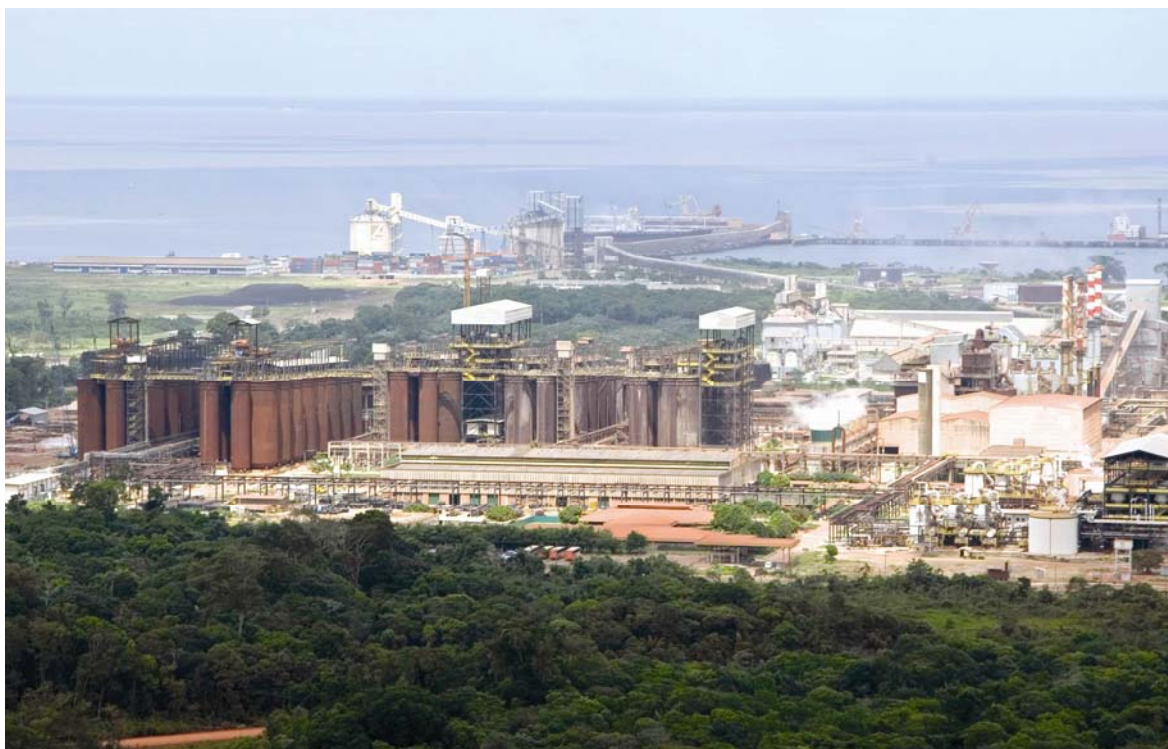
Figura 2: Vista geral da Alunorte e, ao fundo, o porto de Vila do Conde.
