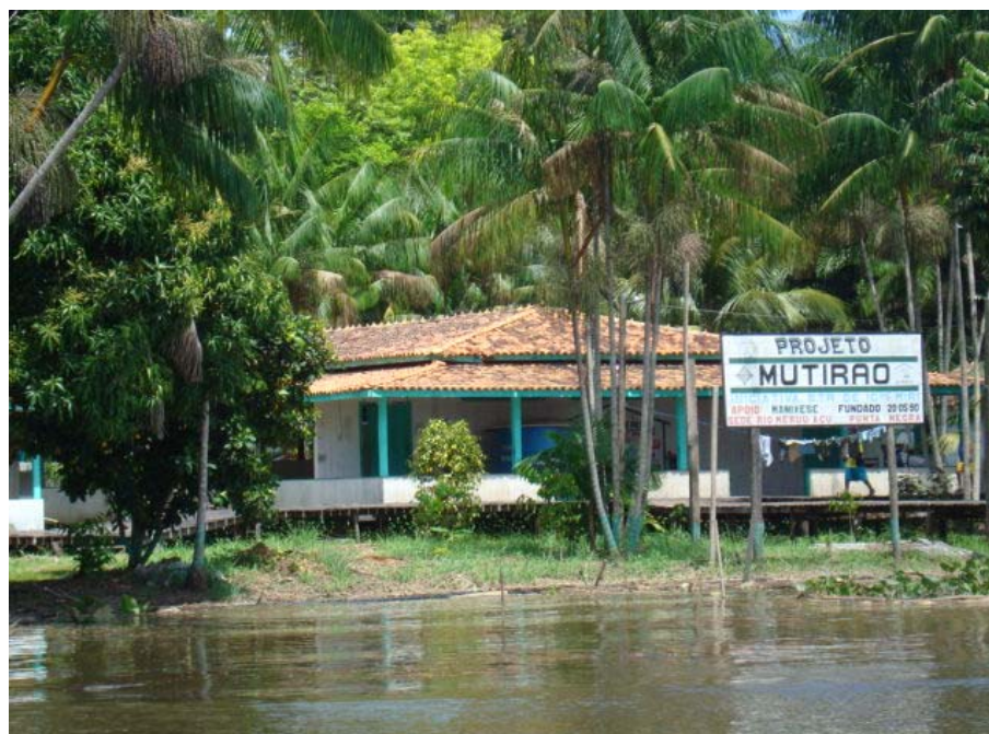
Fotografia 14 – Visão da fachada do Projeto Mutirão na várzea de Igarapé-Miri
