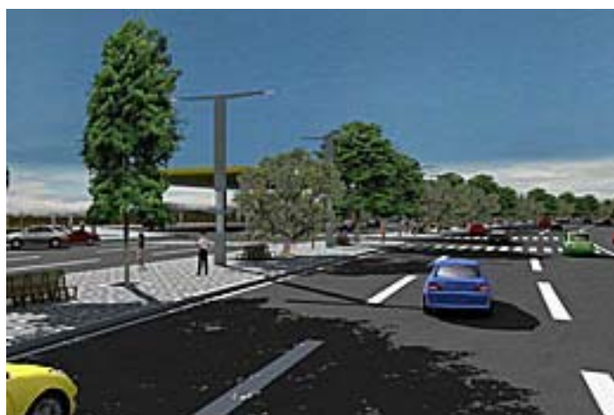
Imagem 2 – VIAS DO “PORTAL DA AMAZÔNIA” – notar o privilégio dado à circulação dos carros e que as pessoas representadas na imagem aparecem posicionadas para observar o rio, a cidade vira espetáculo a ser visto. Fonte: Cosmus (2006).
