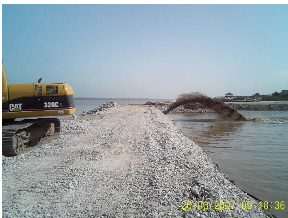
Fotografia 3 – PRIMEIRA FORMA DE ATERRAMENTO DA ORLA – podemos observar a tubulação chegando à beira-rio e aterrando-a com aterro proveniente do próprio rio. Fonte: Jorge Souza (26.06.2007).
