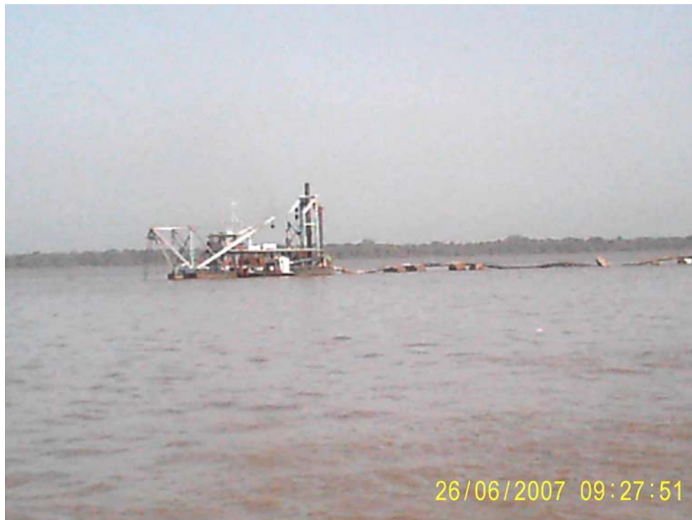
Fotografia 2 – RETIRADA DE ATERRO HIDRÁULICO – notar o grande tubo que sai da balsa drenando aterro do fundo do rio, tubo este que chega até as margens trazendo o aterro. Fonte: Jorge Souza (26.06.2007).
