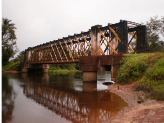
Fotografia 1 - Ponte sobre o Rio Maracanã, comunidade do Livramento. Foto de Luiz Melo Júnior (2011).
