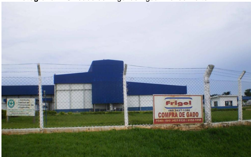
Fotografia 4- Unidade do Frigor de Água Azul do Norte
