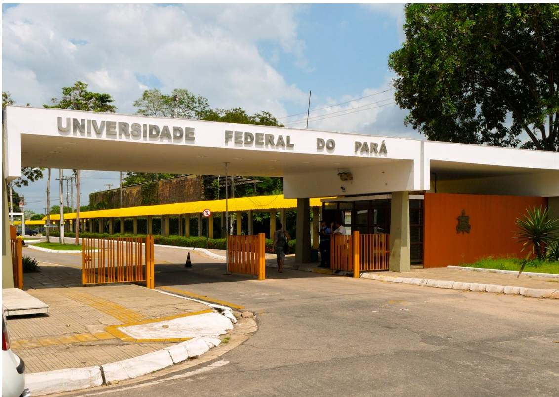
Fotografia 1 – Perfil da fachada da UFPA, campus Belém
