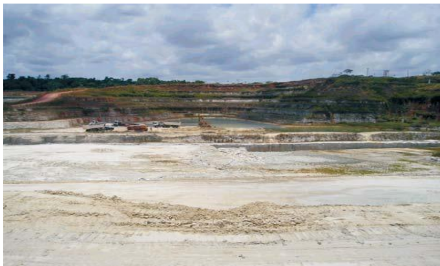
Fotografia 3 - Vista da Mina de Calcário B-17.
