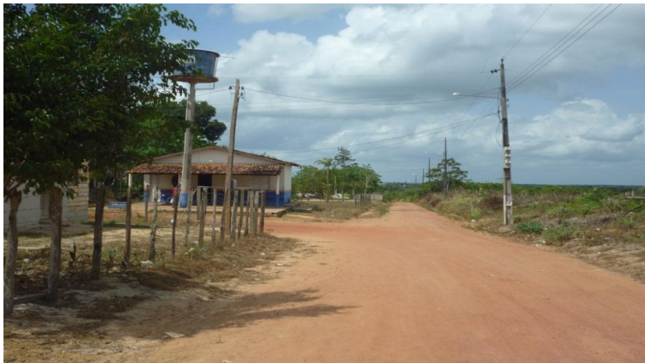
Fotografia 7 - Presença de luz elétrica na comunidade Mata Sede
