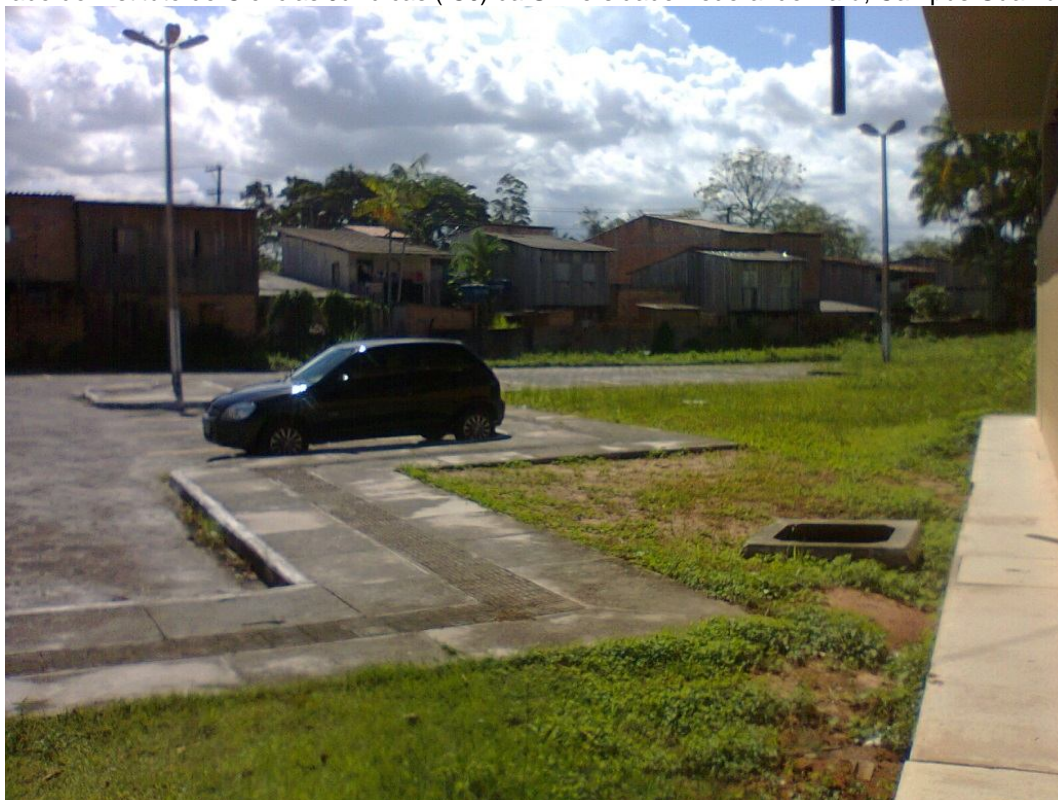
Fotografia 8 - INSTITUTO DE CIÊNCIAS JURÍDICAS E O ENTORNO, Ocupações do tipo favela ao lado do Instituto de Ciências Jurídicas (ICJ) da Universidade Federal do Pará, Campus Guamá
