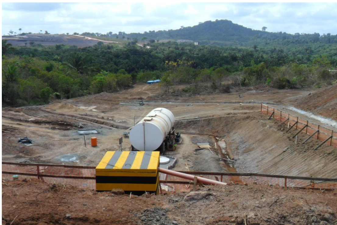
Fotografia 5 - Vista parcial do canteiro de obras Belo Monte
