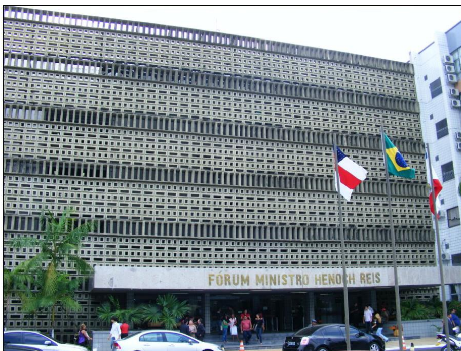
Fotografia 1- Prédio do Poder Judiciário em Manaus/AM
