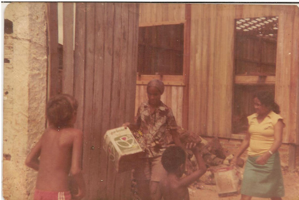
Fotografia 6 - Mutirão na Cobajur para construção da Escolinha Comunitária Santo Dias.
