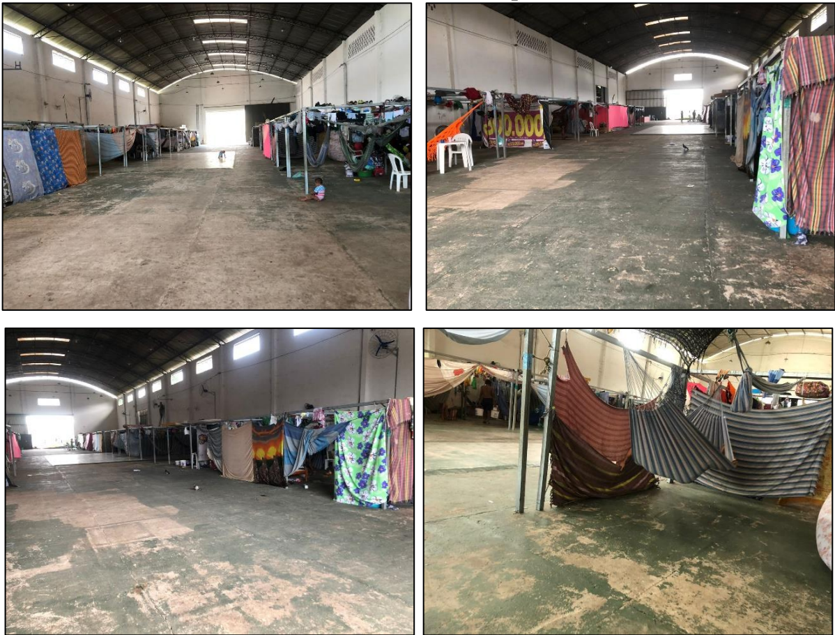
FIGURA 42, 43, 44, 45, 46 e 47 – Galpão Dormitório 3
