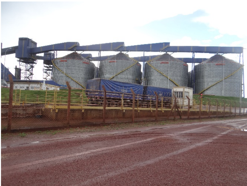
Figura 68 – Visão dos Silos da ETC HBSA, a partir da Transportuária
