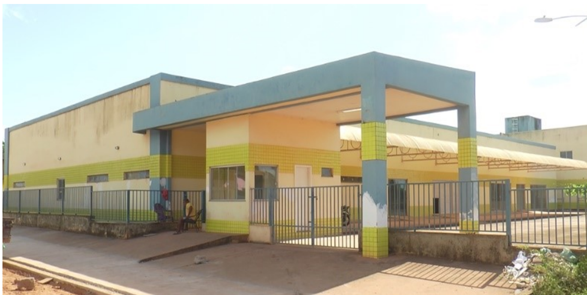
Figura 78 – Fachada frontal da edificação construída para abrigar a UPA
