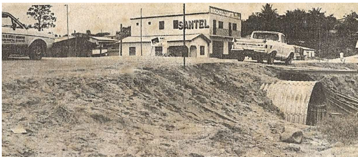
Figura 23 – Serviços de drenagem no igarapé oriundo para sua sobreposição viária (Tv. 13 de maio)
