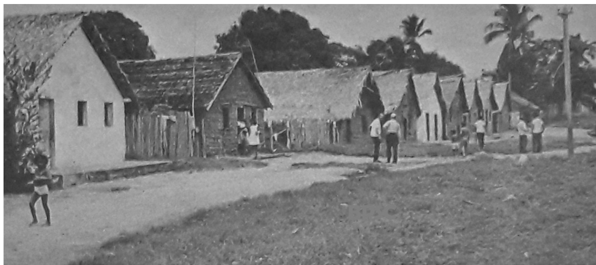
Figura 09 – Vista de uma rua da cidade de Itaituba, na década de 1960
