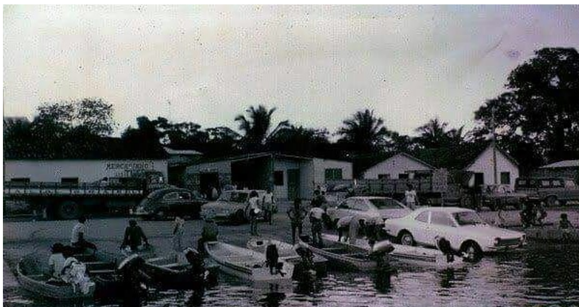
Figura 21 – Foto do porto da balsa de travessia sobre o rio Tapajós, em 1979
