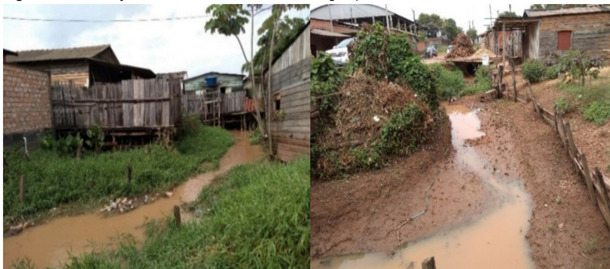
Figura 92 – Edificações identificadas sobre o leito do igarapé Oriundo
