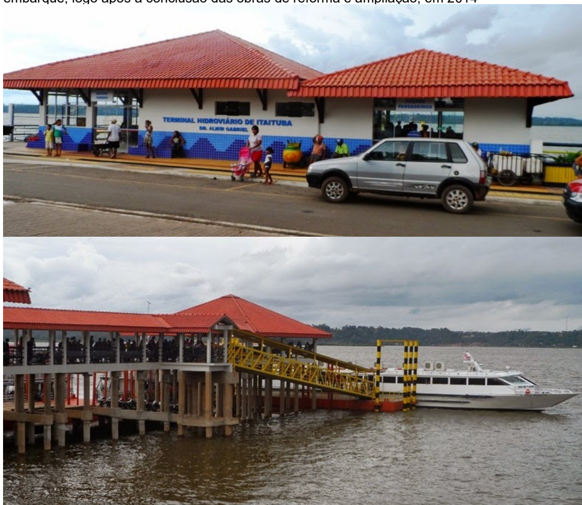
Figura 74 – Mosaico de fotos da fachada frontal do terminal hidroviário e da plataforma de embarque, logo após a conclusão das obras de reforma e ampliação, em 2014
